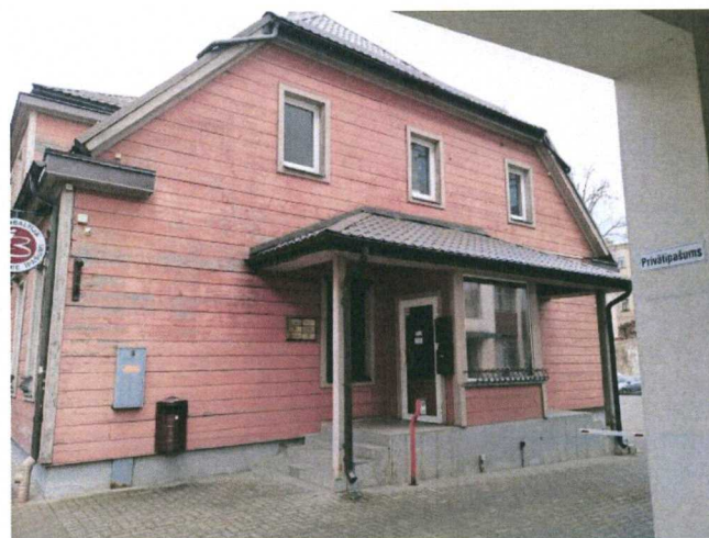
4.att. Fasādes daļa (austumi)
