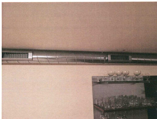
39.att. Ventilācija. Mehāniskā nosūce
